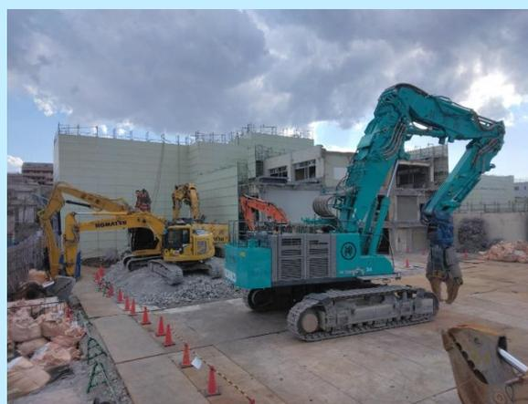
3枚目の写真は、現在の校舎棟全景です。白色のシールドに覆われており、建物内部の壁などを取り壊しています。
